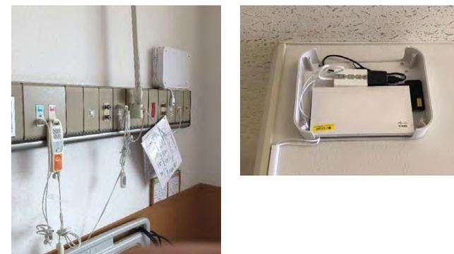
BLEセンサ付き無線LANアクセスポイントは病棟壁面や個室メディカルコンソール、個室トイレなどに設置。
